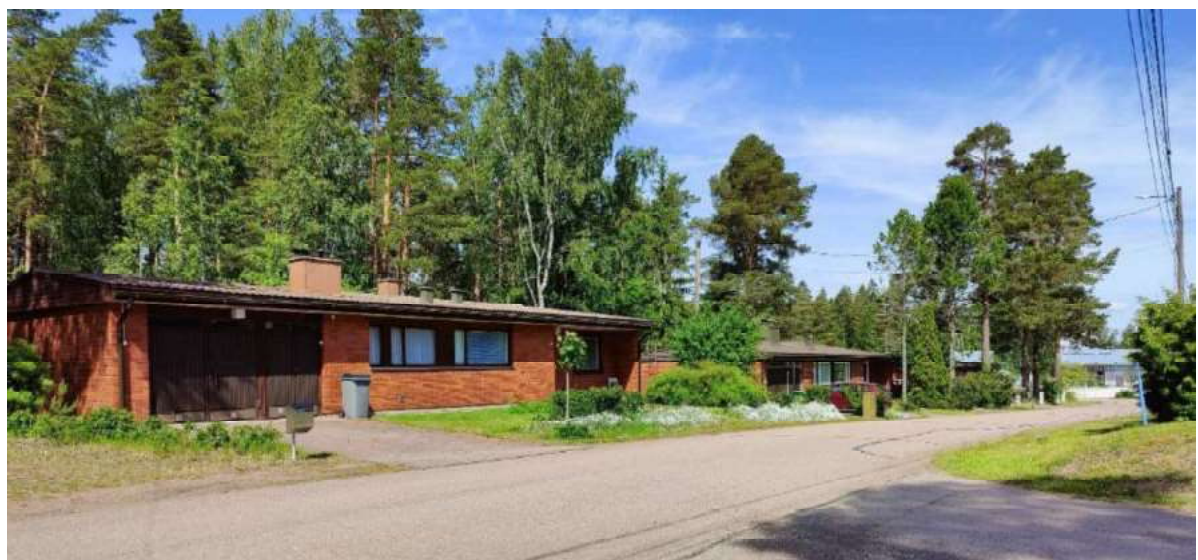
Alueen tyypillinen omakotitalo on yksikerroksinen, punatiilipintainen ja harjakattoinen.
