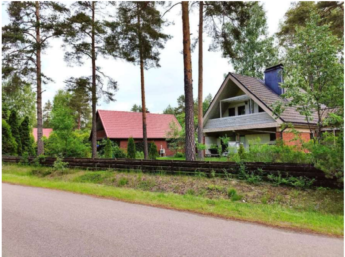
Mäntyrannantien alkupään omakotitaloja.
