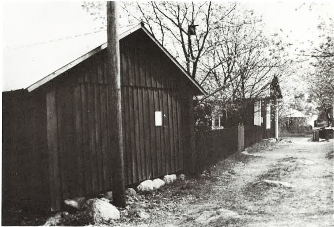
Kuva 13. Mäkelän talo kujalta katsottuna.
