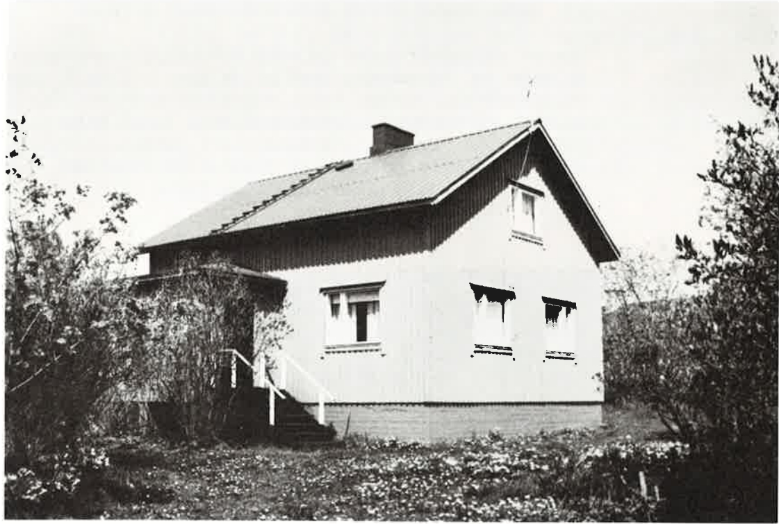
Kuva 33. Veikko Tynin päärakennus. Rakennettu 1940-luvulla.
