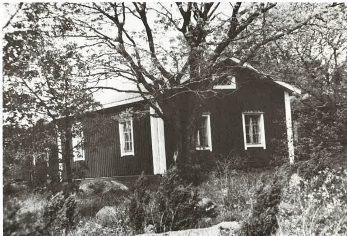
Kuva 18. Einolan talon päärakennus.
