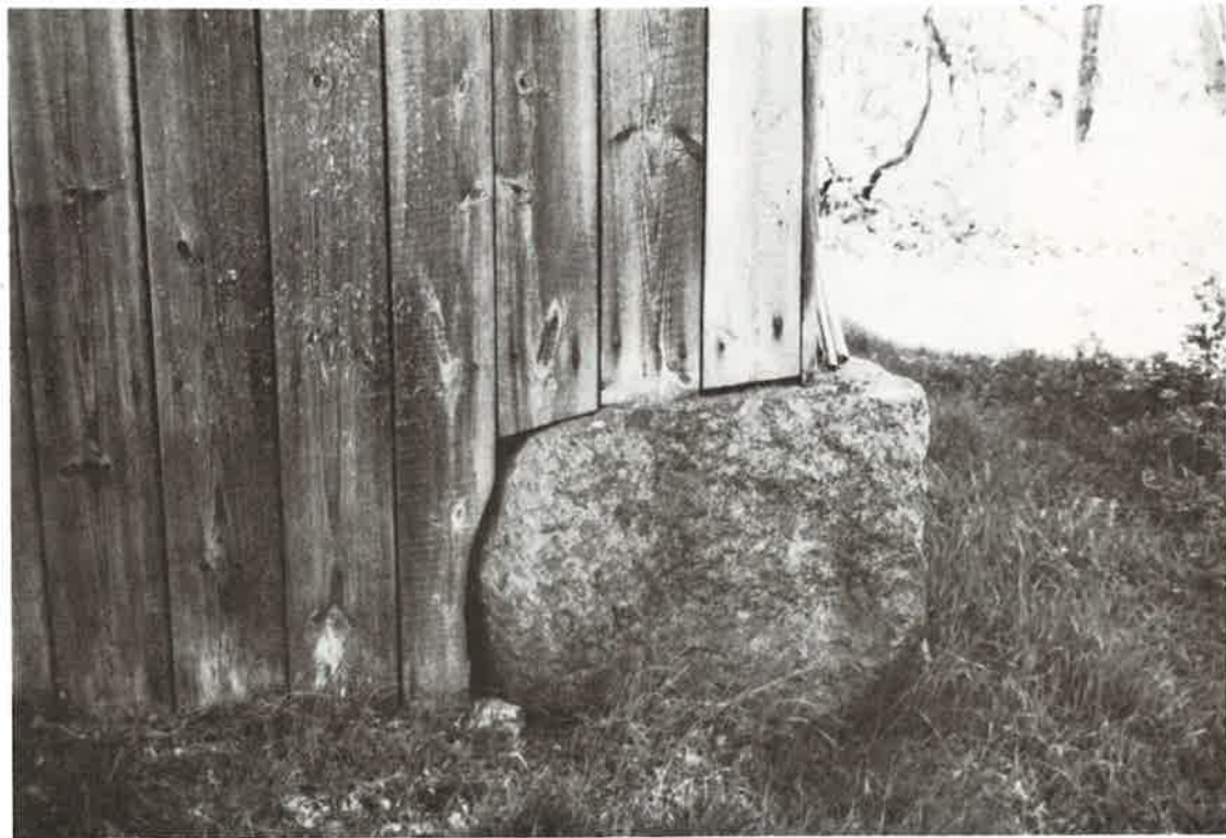
Kuva 20. Aittarakennuksen kiviperustus.
