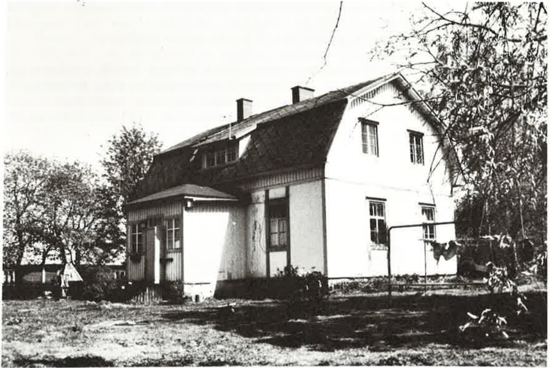
Kuva 30. Pekon talon päärakennus.
