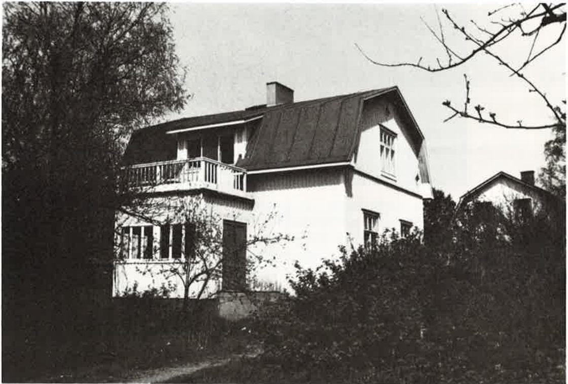
Kuva 32. Viljo Tynin päärakennus aloitettu 1930-luvulla.
